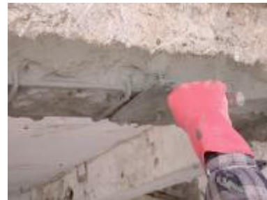
3. KÖSTER Repamor ile tamirat tamamlanır.
