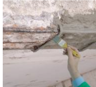
2. Demir donatı KÖSTER Adex ile kaplanır.
